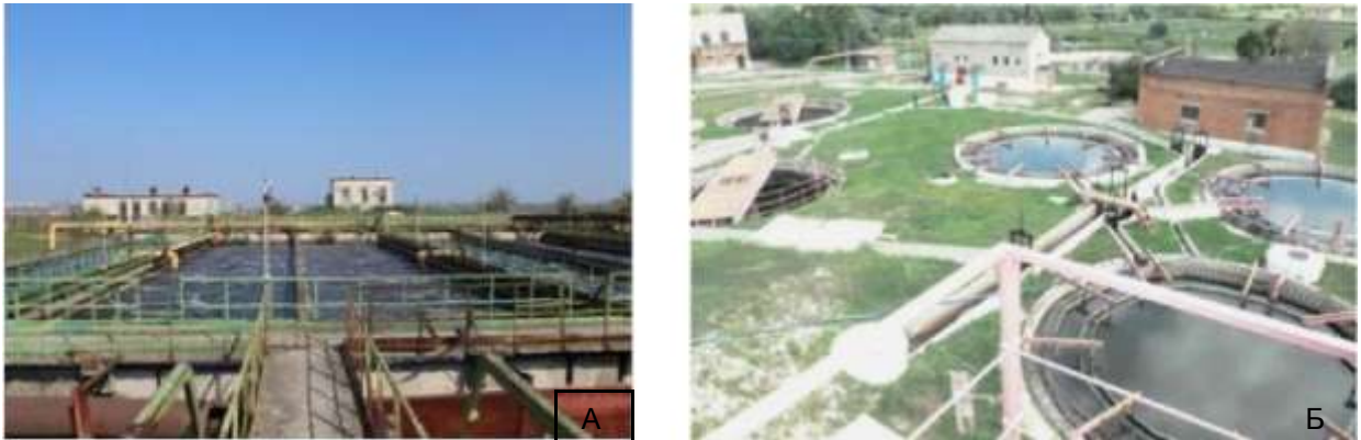
Рис. 4.33. Очистные сооружения: А - Аэротенк в г. Губкине, Б - МУП Водоканал г. Валуйки
